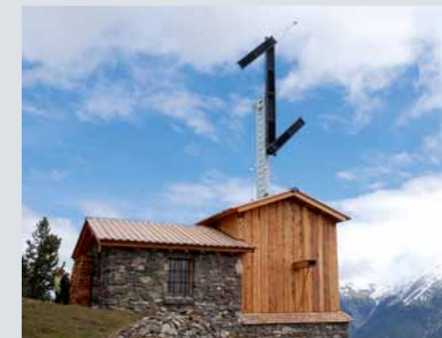
La station du télégraphe Chappe rénovée par l'Ahapss. © François Pebay
