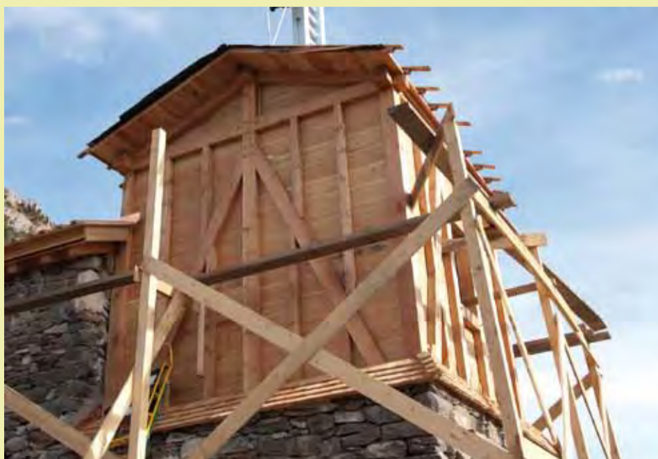
Restauration du télégraphe Chappe situé au Mollard Fleury. Commune de Sollières-Sardières.
